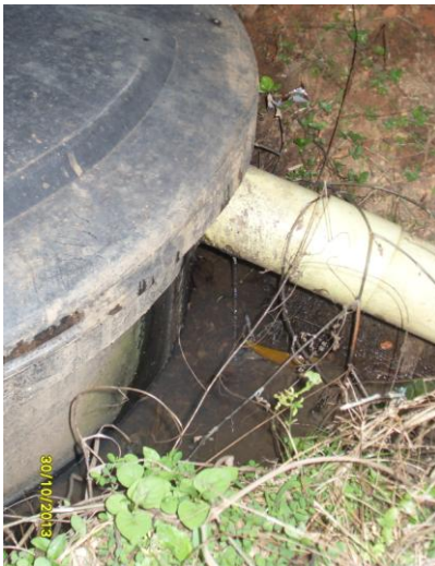
Pozo séptico que presentó infiltración de aguas residuales directa al suelo
