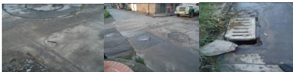
Presencia de fisuras en placas nuevas, presencia de daños en tapas de cámaras y sumideros
