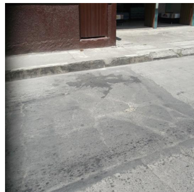
Imagen No. 2 Reparcheo ya fracturado, mala calidad de la ejecución
