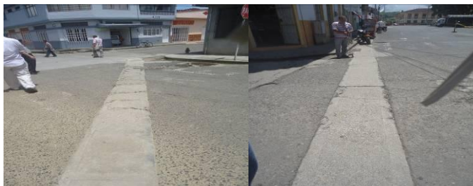
Placas con presencia de fisuras Municipio de Sevilla
