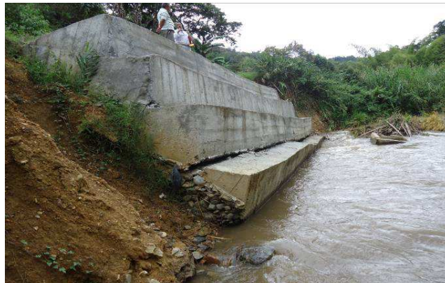
FOTO6. MURO PARTE BAJA CONT. 002 C.H. Mario Correa Luna K8+000 Volcamiento gaviones socavación
