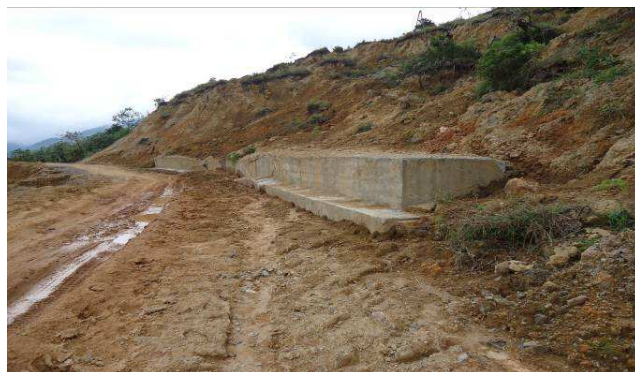
FOTO8. DAÑO MURO CONT.001 C.H. Ancisar de Jesús Bedoya Henao. Falla por Asentamientos diferenciales y empuje
