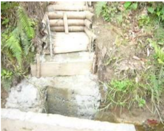
Predio La Tribuna, trabajos de recuperación de áreas degradadas, canalización y evacuación de aguas que afectaban el terreno y construcción de trinchos
