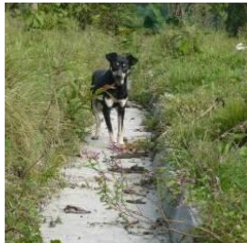
Canaleta para escorrentía de aguas lluvias-se observó falta de mantenimiento
