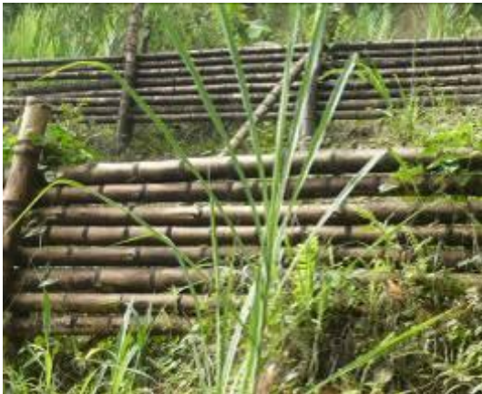
Trinchos en guadua recuperación áreas degradadas
