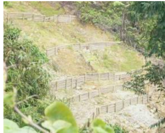
Predio La Tribuna, trabajos de recuperación de áreas degradadas, canalización y evacuación de aguas que afectaban el terreno y construcción de trinchos
