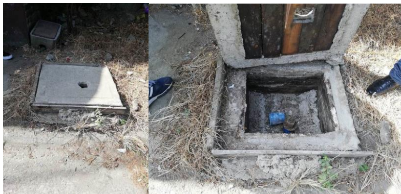
Imágenes de las cajas válvulas instaladas
