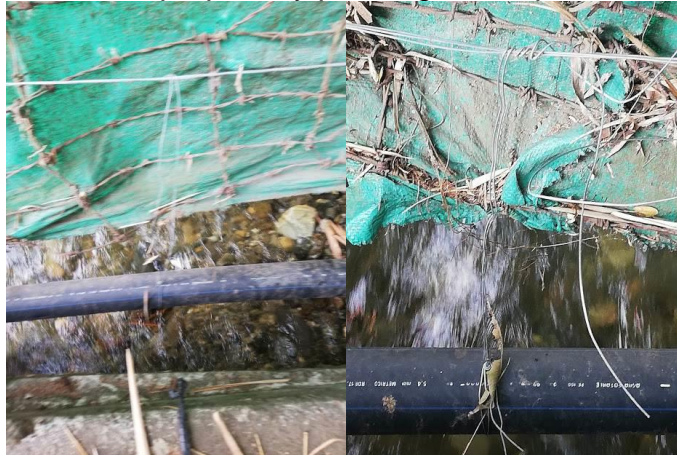
Imágenes de tubería sostenida con alambre
