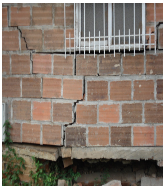
Alto grado de agrietamiento de paredes en vivienda urbana
