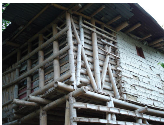
Alto grado de agrietamiento de paredes en vivienda urbana
