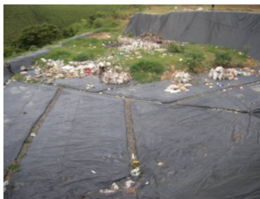
Geomembrana del microrelleno, obsérvese el estado de enmalezamiento y deterioro de ésta
