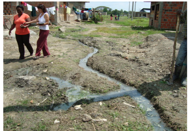
problema de aguas servidas inundando la vía y causando contaminación por malos olores
