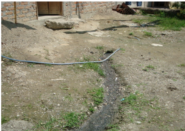
Canalización superficial manzana B por colmatación de pozos Sépticos.
