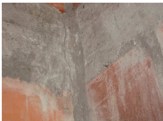
Fractura en viga aérea
