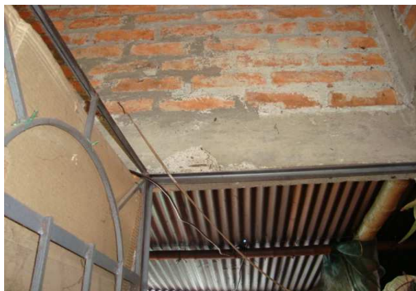
Fractura en vigas
