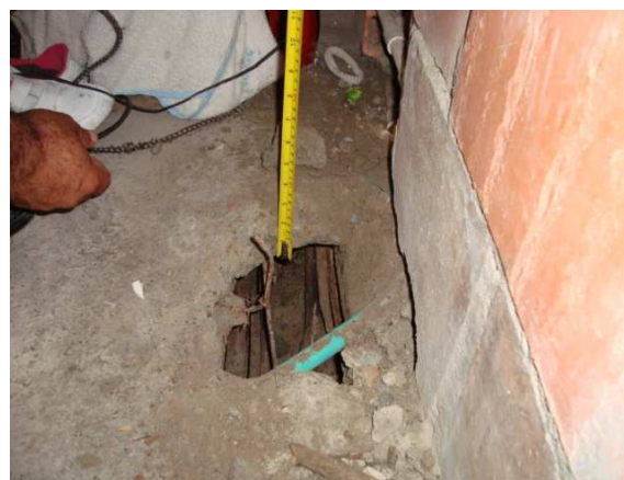
Medida de la losa y confrontación de la falta de geotextil
