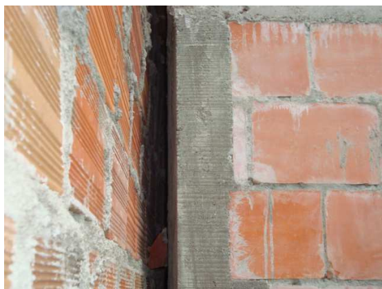
Columnas mal erigidas
