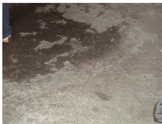
Humedad y deterioro progresivo el piso
