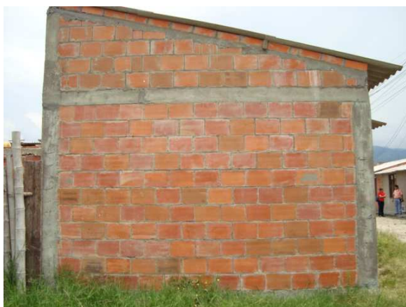
Se evidencia aspectos asimétricos de la construcción de columnas y muros
