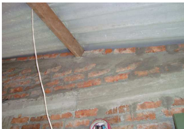
Confinamiento de las vigas de chanul y terminación de la culata
