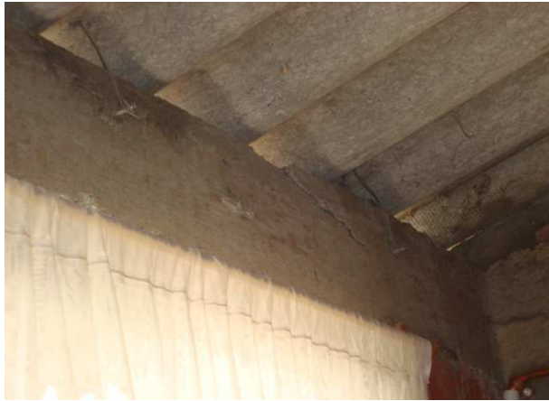
Se evidencia fractura en la viga aérea
