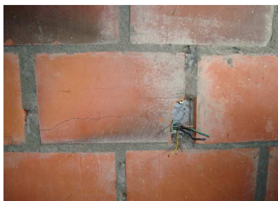
Cajas eléctricas sin tapa y sin terminación
