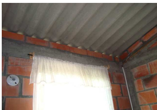
No existe amarre de la cubierta
