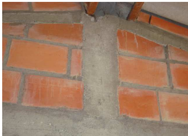
Mala terminación de la culata y colocación de las vigas que no están culminadas
