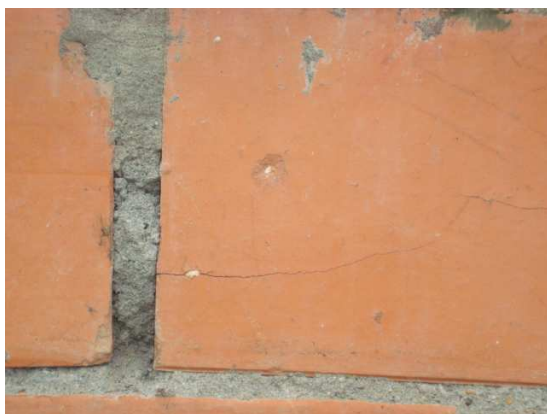
Fractura y calidad de la pega
