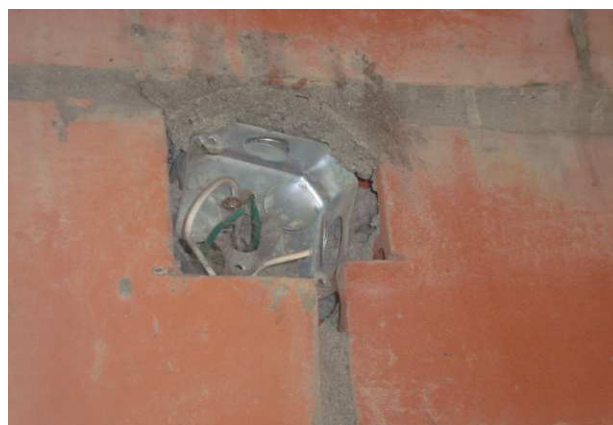
Cajas eléctricas sin tapa y sin terminar
