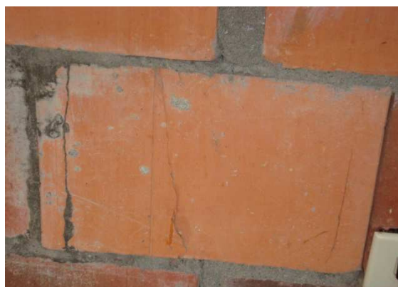
Fractura en el ladrillo estructural
