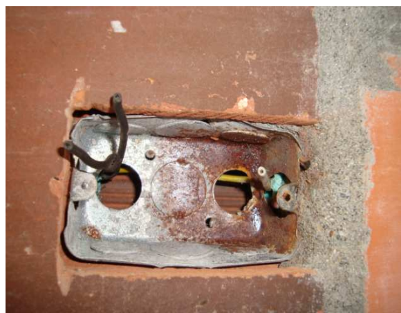
Colocación y sujeción de las cajas eléctricas Que no tienen utilidad
