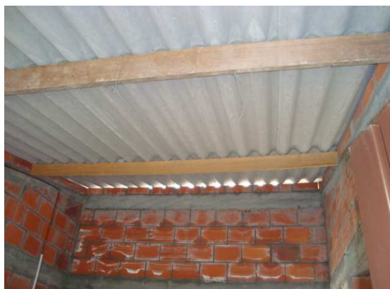
Humedad en la pared y falta de alero
