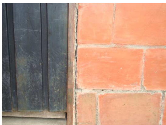
Agrietamiento en la pega del marco puerta de entrada
