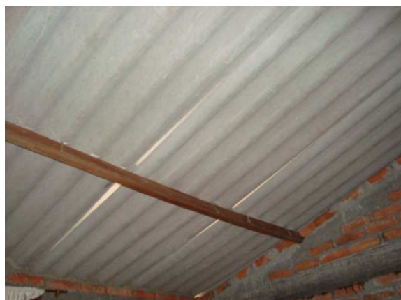
mala colocación de las tejas
