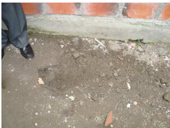
Existe un relleno de 0.15 ml y no de 0.30 m
