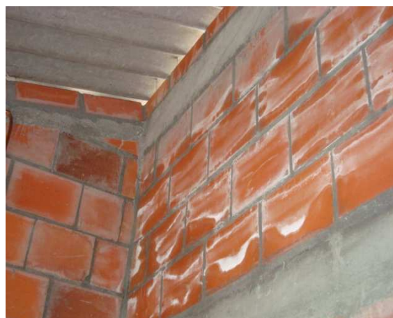
Humedad en la pared. En la colocación de las tejas no dejaron alero.
