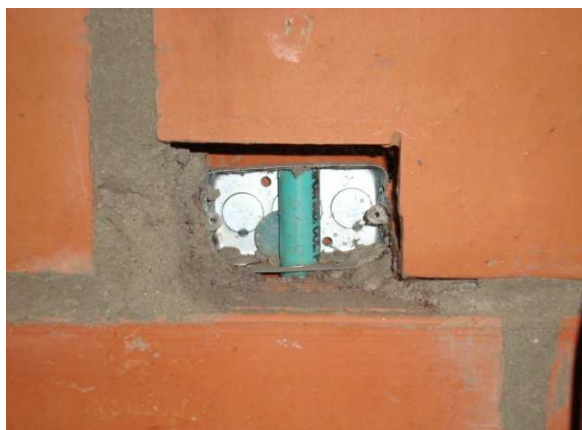
Colocación de caja eléctrica sin utilidad
