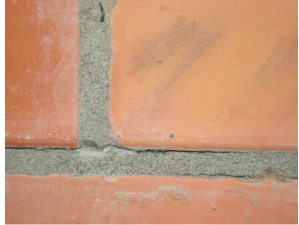
Agrietamiento del mortero de pega del ladrillo estructural
