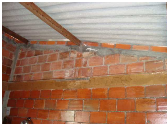
Culatas desalineadas y cubierta mal colocada junto con las vigas
