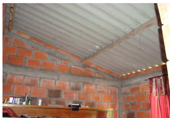
Evidencia de vigas de madera mal colocadas
