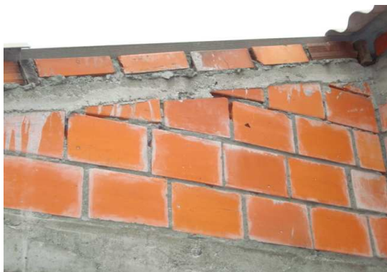
No existe buena pega de ladrillos de la culata
