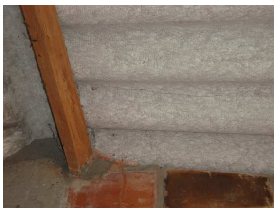
Confinamiento de las vigas de chapul
