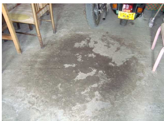
Piso con Humedad y desgaste
