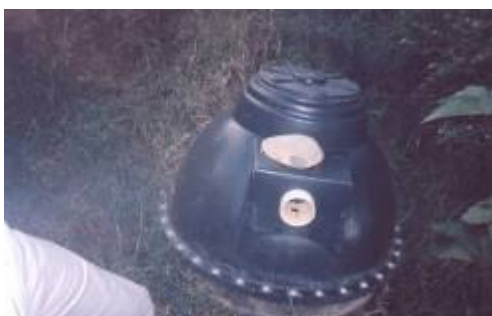
Vda. El Limón –finca El Reposo: sistema instalado, funcionó solo un mes debido a fallas de tornillos, ocasionó malos olores, fue desinstalado- trampa de grasa utilizada para bebedero de animales. sistema séptico no está cumpliendo su propósito
