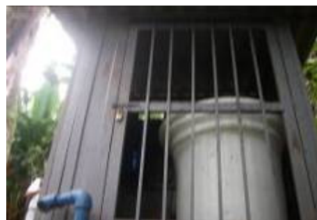
Municipio de Yotoco - Caseta de cloración instalada en la vda. Totoró 2 Bayano, en funcionamiento-falta de mantenimiento
