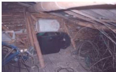
Vereda limones- Sistema séptico instalado parcialmente, no fueron enterrados sus componentes de acuerdo a las indicaciones técnicas, la trampa de grasas no fue instalada, ni caja de inspección –debido a falta de tubería (Finca La Esquina).
