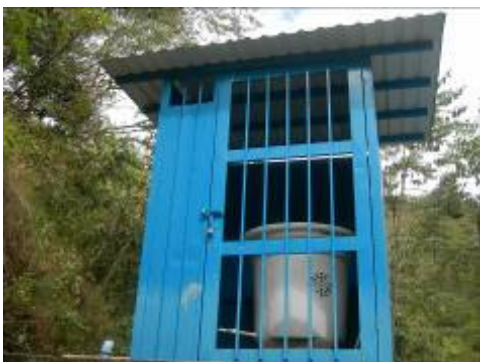
Casetas de cloración de las veredas El Rincón (Mpio. de La Unión) y Marcópolis (Mpio. de Obando), al momento de las visitas no se encontraban en funcionamiento.
