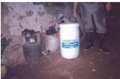
Municipio de Roldanillo - Sistema de desinfección vereda Armenia2 –caseta metálica, tanque de cloración e insumos. No se está clorando el agua de consumo humano.
