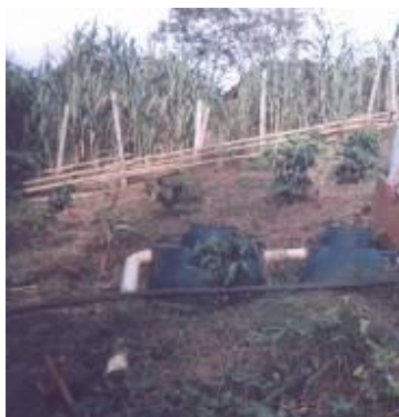
Vereda limones- Sistema séptico instalado parcialmente, no fueron enterrados sus componentes de acuerdo a las indicaciones técnicas, la trampa de grasas no fue instalada, ni caja de inspección –debido a falta de tubería (Finca La Esquina).
