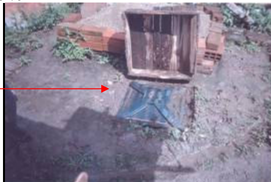
Vda. Cabuyal (finca Alto bonito): sistema funcionando, se protege trampa grasa y caja de inspección, mantenimientos periodicos
