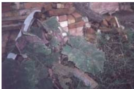
Vereda La Aguada (Finca El Descanso): Sistema completamente tapado por ladrillos y maleza, daño en tapa de trampa grasa, se percibieron malos olores.
