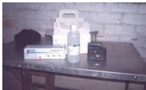
Municipio de Roldanillo - Sistema de desinfección vereda Armenia2 –caseta metálica, tanque de cloración e insumos. No se está clorando el agua de consumo humano.
