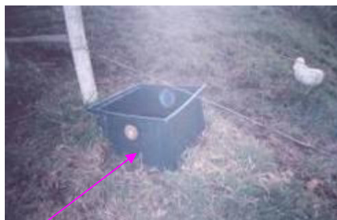
Vda. El Limón –finca El Reposo: sistema instalado, funcionó solo un mes debido a fallas de tornillos, ocasionó malos olores, fue desinstalado- trampa de grasa utilizada para bebedero de animales. sistema séptico no está cumpliendo su propósito
