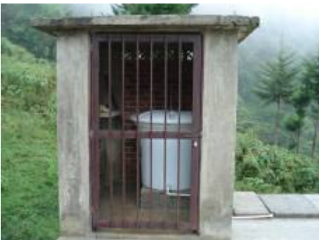
Municipio de Palmira -Caseta de cloración y cuñete de cloro en el corregimiento de Arenillo (Palmira)
