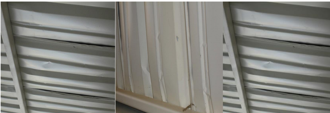
Cielo falso en panel yeso que presenta grietas y sugiere desprendimiento.
