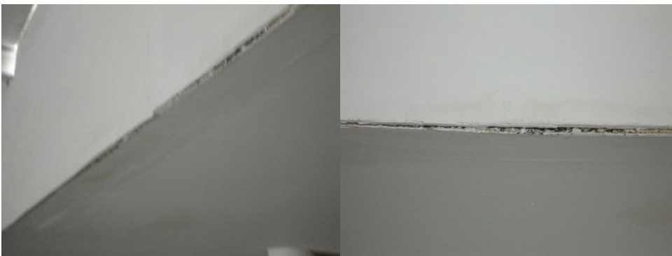
Cielo falso en panel yeso que presenta grietas y sugiere desprendimiento.
