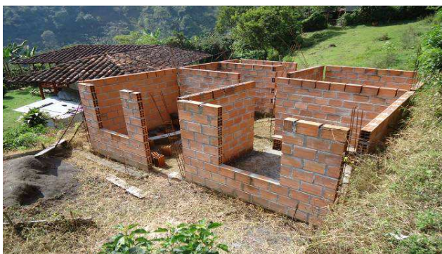
FOTO4. Conv. 113 construcción vivienda social El Aguila Corporación Vivienda Digna. Elevación muros
