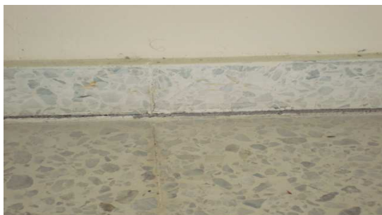
Hundimiento piso Pared intervenida colindante con urgencias
