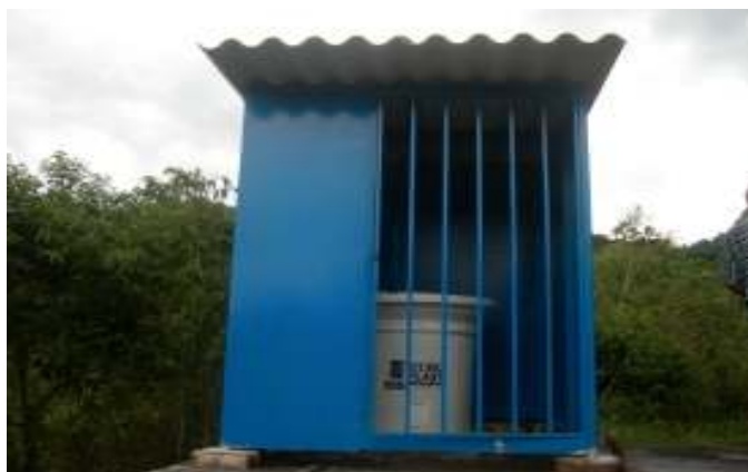
Municipio Buga – Caseta de cloración vereda Sonsito. No se esta clorando por problemas de turbiedad.
