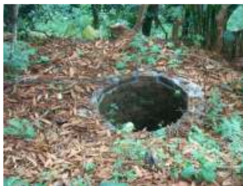
Municipio de Bolívar - sistema séptico vereda instalado vereda El Tunó. Pozo de infiltración
