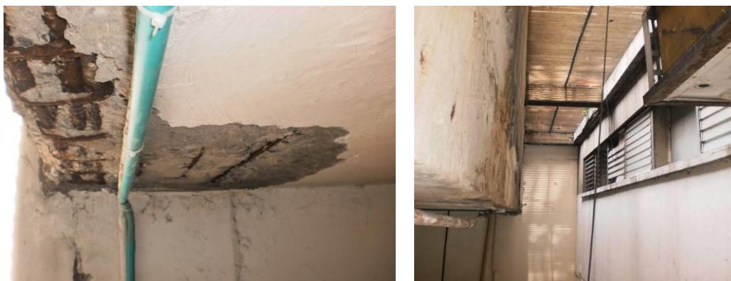
Concreto deteriorado por consistencia del material parte externa
