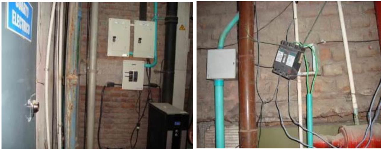
Tubería en deterioro hidrosanitaria pasando por estos espacios cableados eléctricos
