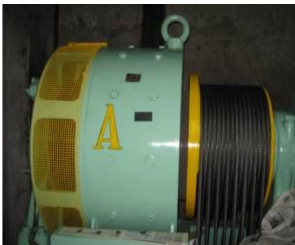
Motores A y C se repararon, estos volvieron a sufrir daños irreparables en sus tarjetas electrónicas y parte eléctrica.
