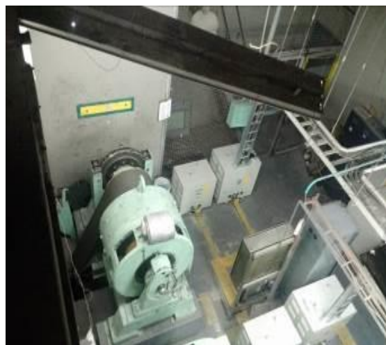
Motores A y C se repararon, estos volvieron a sufrir daños irreparables en sus tarjetas electrónicas y parte eléctrica.
