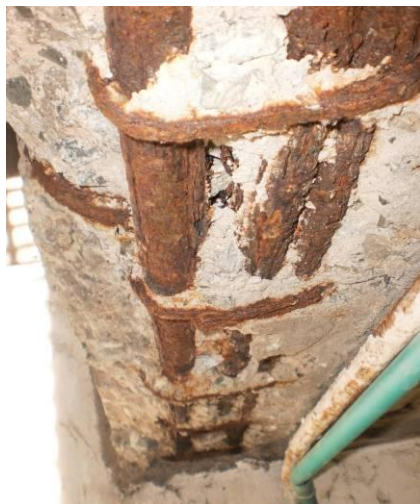
Carbonatación y oxidación en columnas Debilitamiento de la estructura de hierro en vigas y humedad en paredes
