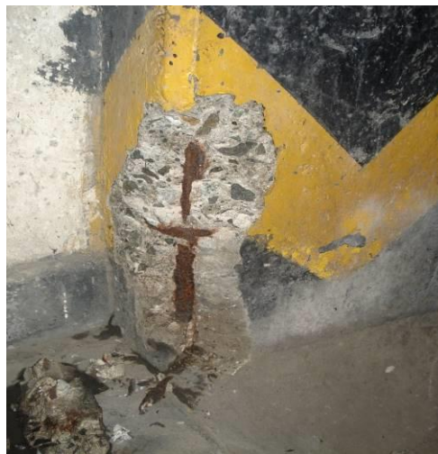
Carbonatación y oxidación en columnas Debilitamiento de la estructura de hierro en vigas y humedad en paredes
