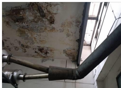
Deterioro de los cielos rasos por rompimiento de tuberías ubicación sótano
