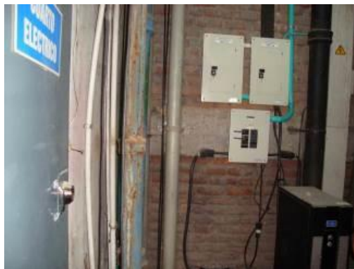
Tubería en deterioro hidrosanitaria pasando por estos espacios cableados eléctricamente
