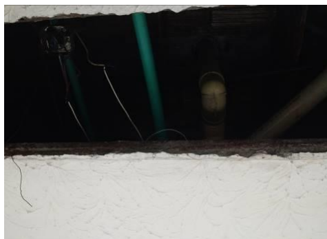
Tuberías sanitarias obstruidas, fugas de agua a través de ductos que combinan con las redes eléctricas en los baños.
