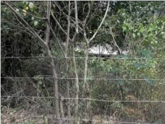
Utilización de los arboles como postes 5 hilos de alambre
