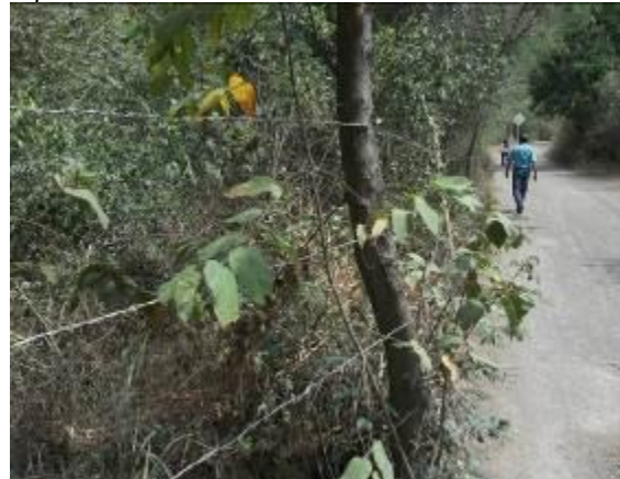
Utilización de los arboles como postes 5 hilos de alambre
