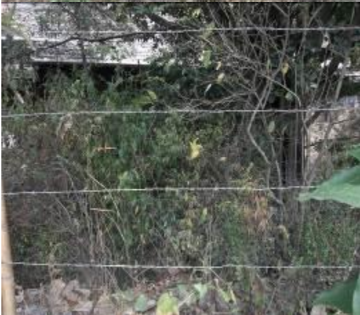
Posteatura de mala calidad y diferentes distancias entre alambre, obsérvese menor cantidad de hilos de alambre
