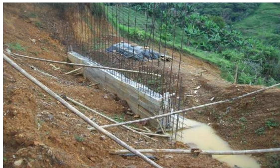
Contrato 003 Construcción alcantarilla y cunetas
