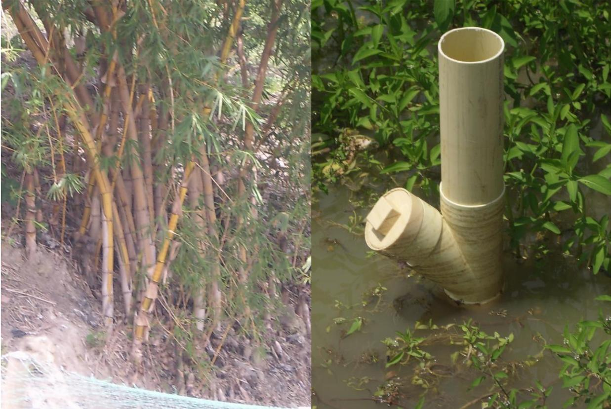
\* En estas imágenes se puede apreciar parte de la reforestación y recuperación del terreno y un filtro de desagüe y control de los gases de los lixiviados y el metano, para el equilibrio de las aguas residuales
