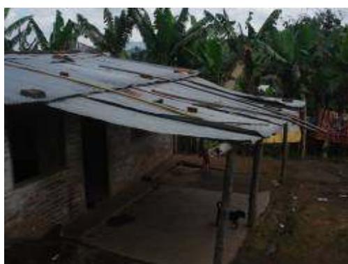
Viviendas mejoradas Terraza delantera en zinc
