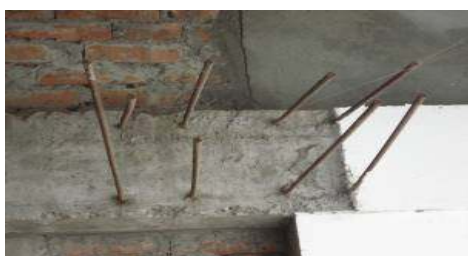
Refuerzo longitudinal de vigas
