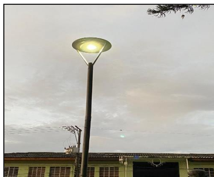
Luminarias del parque sin filtro antideslumbramiento
