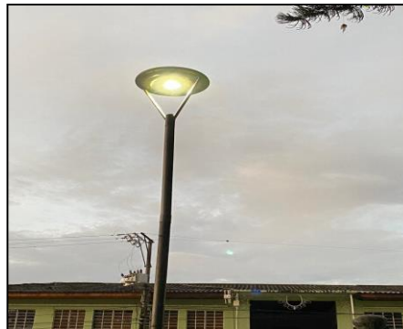
Luminarias del parque sin filtro anti deslumbramiento
