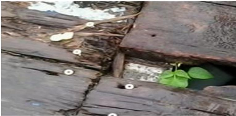
Las reparaciones realizadas y reposición de tablones no han sido instalados cumpliendo con especificaciones técnicas, para este tipo de pisos ya que han quedado con salientes pronunciados y representan un riesgo para los transeúntes para su desplazamiento.
