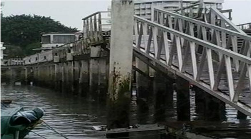
La rampa que comunica las instalaciones de despacho y rampa de acceso, se observó que se encuentra en su punto de apoyo inferior fracturada y con refuerzos expuestos y en proceso de corrosión.
