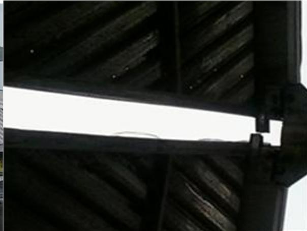
El soporte transversal que unen las columnas en la parte final del muelle presenta un deterioro pronunciado por la corrosión situación que pone en alto riesgo la estabilidad de la estructura flotante.
