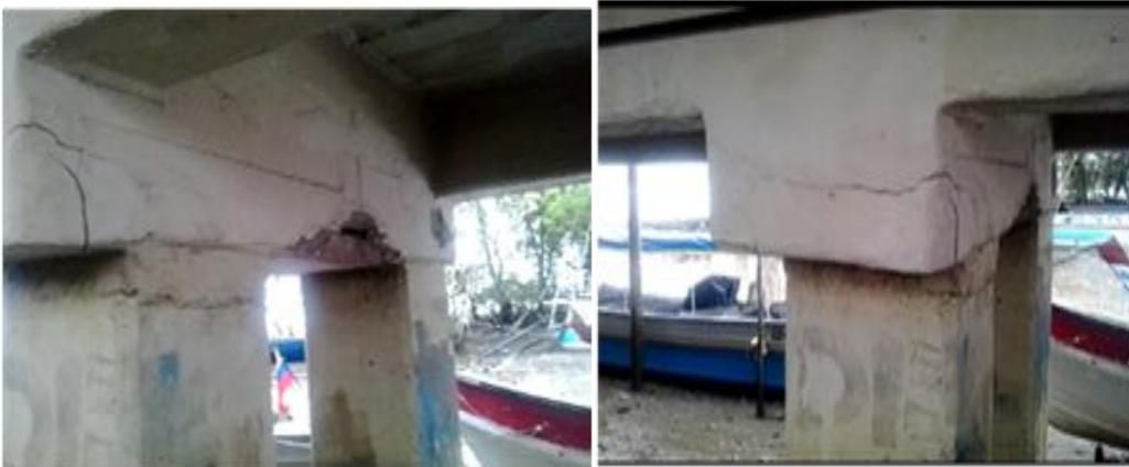
Así mismo en la base de las columnas de soporte se denota que se encuentran desprotegidas y falta recubrimiento.
