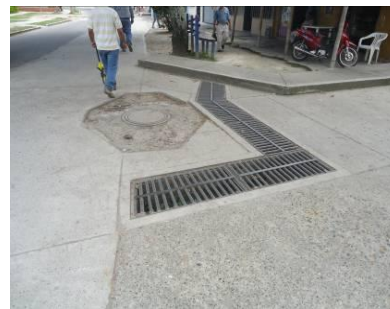
Rejillas para captación de aguas lluvias
