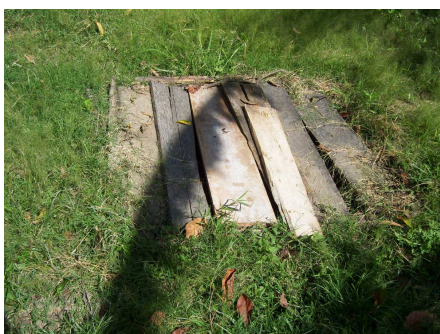
Tapas de los pozos de absorción en mal estado y pozos sépticos que se encuentran totalmente colmatados
