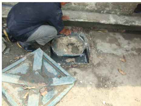
Trampas grasas sin uso al igual que otras sin mantenimiento
