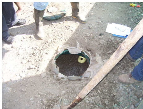
Tapas de los pozos de absorción en mal estado y pozos sépticos que se encuentran totalmente colmatados
