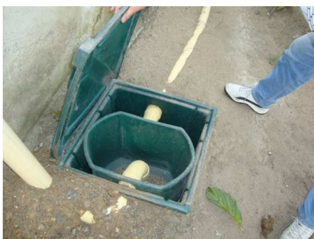
Trampas grasas sin uso al igual que otras sin mantenimiento
