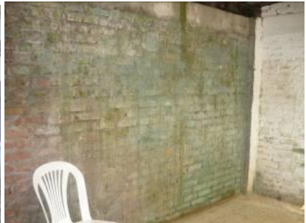
Parte externa e interna de salón de clase afectada por humedad y filtración, separado de montaña por la comunidad indígena.
