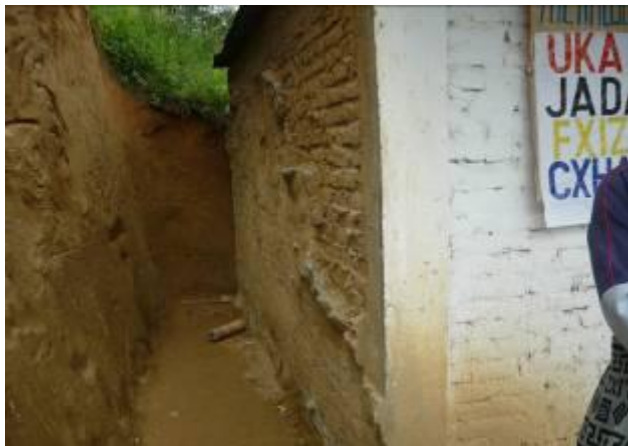
Parte externa e interna de salón de clase afectada por humedad y filtración, separado de montaña por la comunidad indígena.
