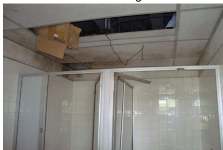
División puertas y cielo falso rotos
