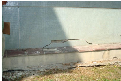
vista de la fractura estructural del muro
