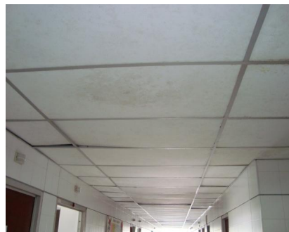
Deterioro por humedad del cielo falso pasillos
