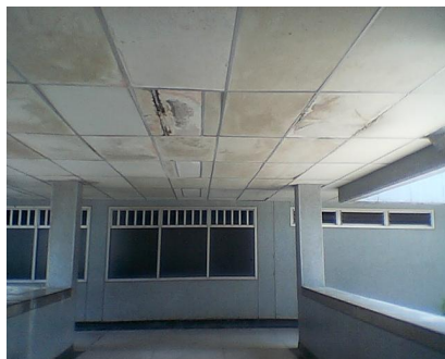
Deterioro por humedad del cielo falso pasillos
