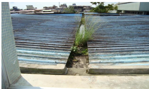
Vista de las canaletas rebozadas de agua y tierra que propician el crecimiento de maleza.
