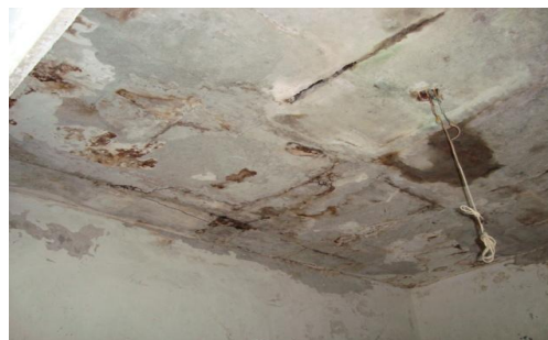
Humedad por filtraciones en la losa producto la falta de mantenimiento
